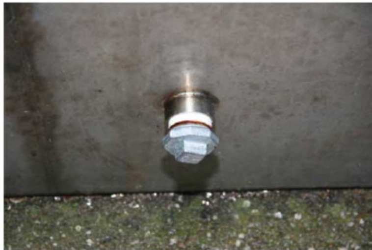
Abbildung 16: Anschlussmöglichkeit für Messfenster nach ÖNORM M 5873-1:2001
